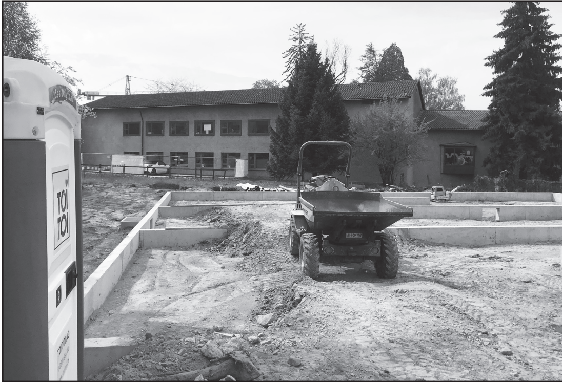
Es geht vorwärts mit dem Schulraum-Provisorium: Das Fundament für das Provisorium im Felsberg steht.
