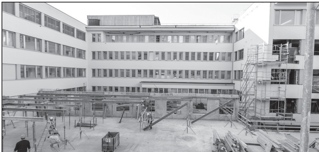
Die Klinik wird schrittweise erneuert: Blick auf die Baustelle.
