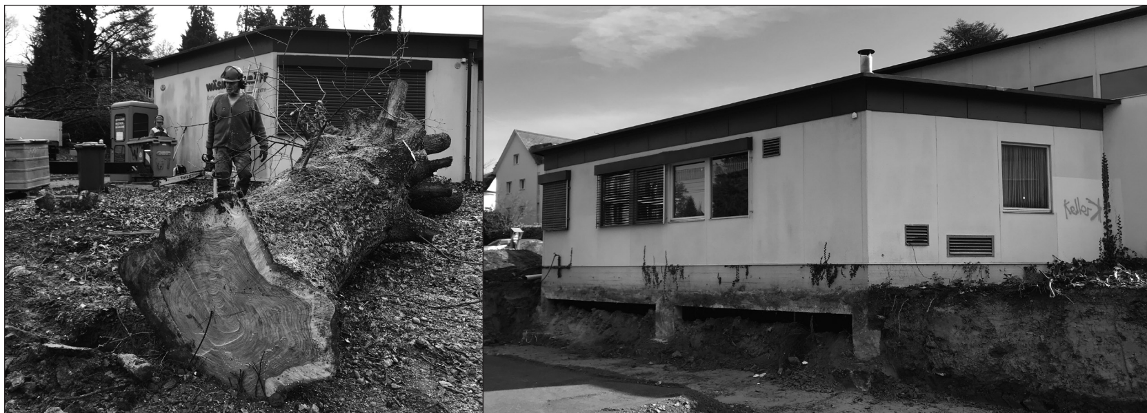
Ungewohnte Anblicke: Die Anfang März gefällte Jubiläums-Eiche und der bis aufs Fundament freigelegte alte Treff kurz vor dem Abriss.
