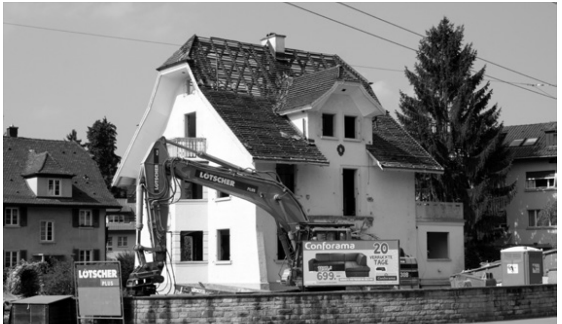
Mettenwylstrasse 1 während des Abrisses
