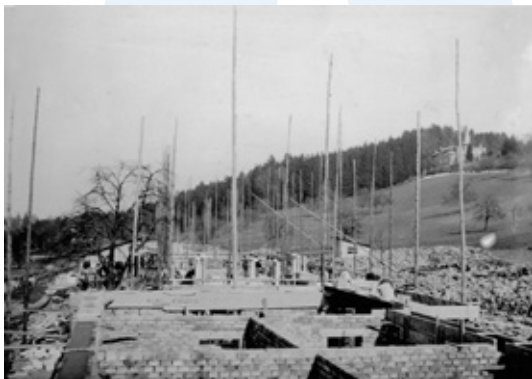
Bau der SBB-Genossenschaftshäuser im Jahre 1924
