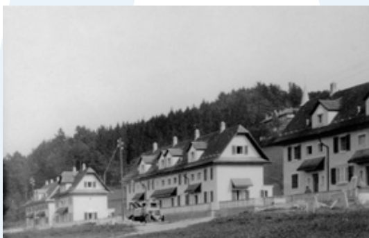
Die ersten Häuser an der Ruflißbergstrasse stehen
