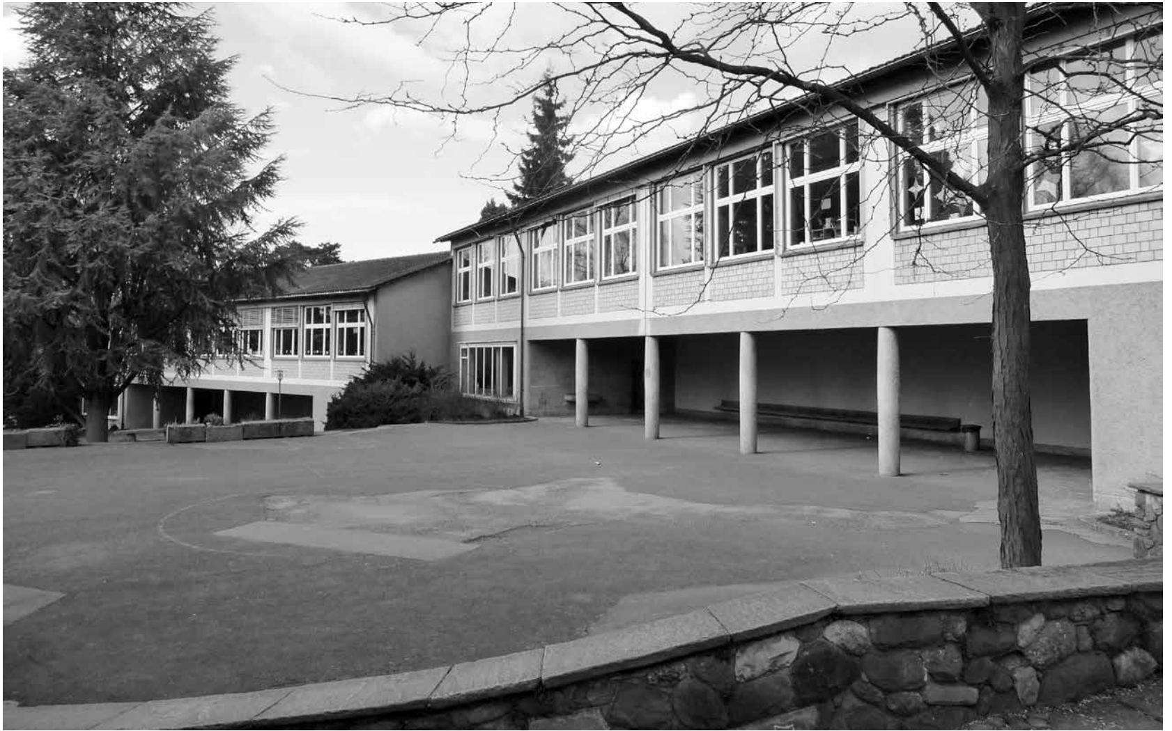
Das Schulhaus Felsberg wird im Frühling 2014 saniert Foto: Walti Portmann
