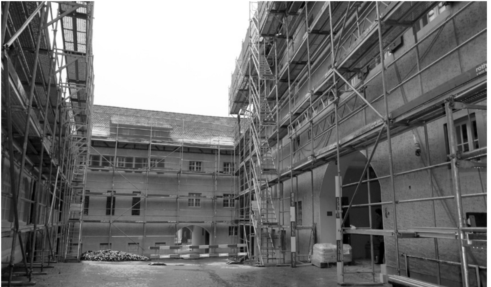
Der Innenhof im Südtrakt: Die Gerüste werden bald abgebaut.
