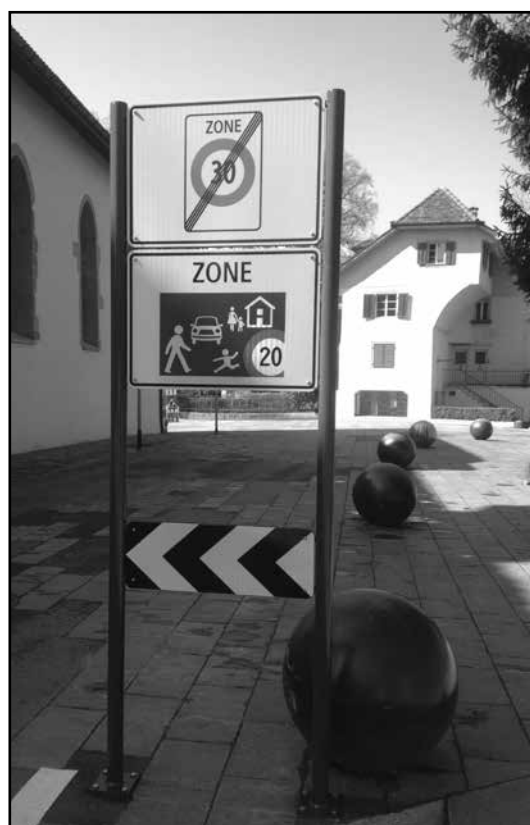
Begegnungszone: Die Oberfläche wird komplett saniert.
