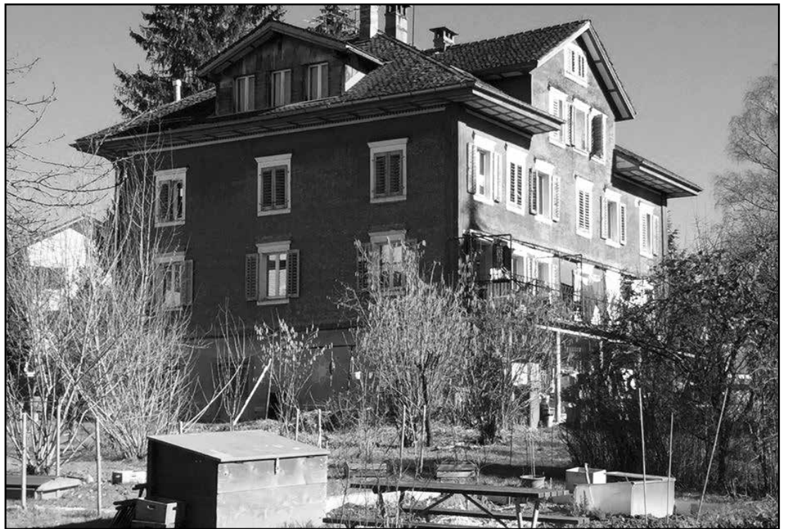
Momentan steht auf dem Areal am Abendweg 17 noch dieses alte Bauernhaus.
