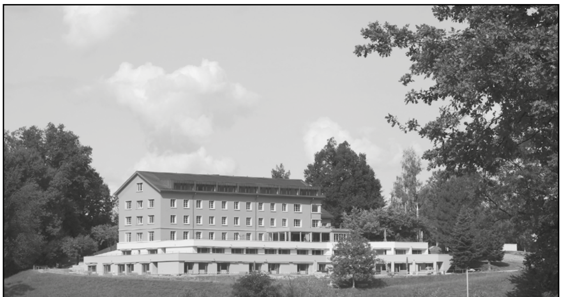
Neue Zimmer im Dachgeschoss: Auf der ganzen Länge wurden Fenster eingebaut.
